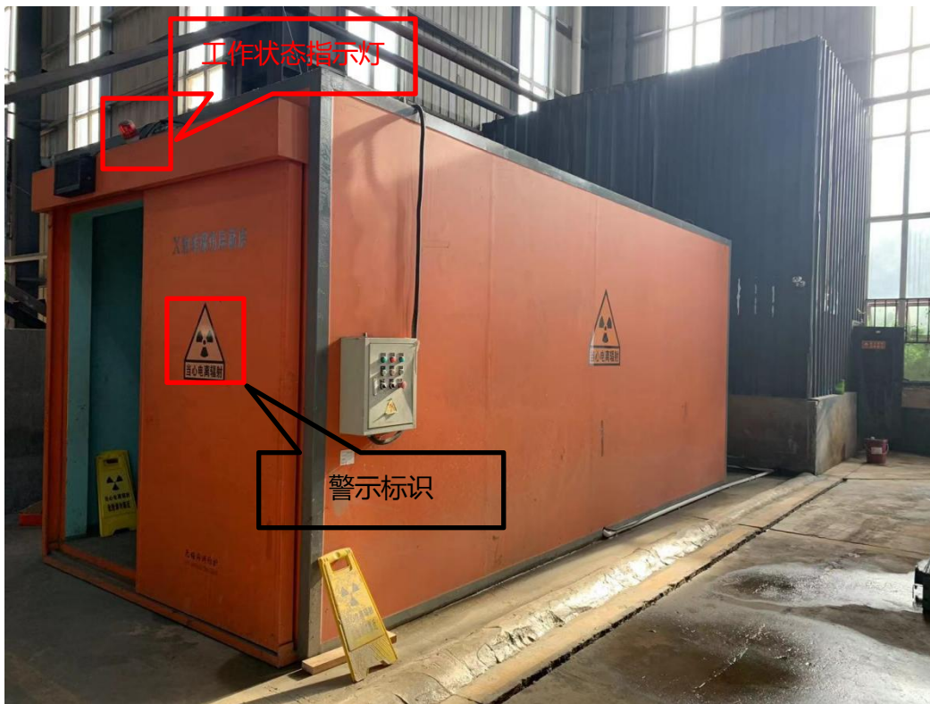
整体式铅房全景图
