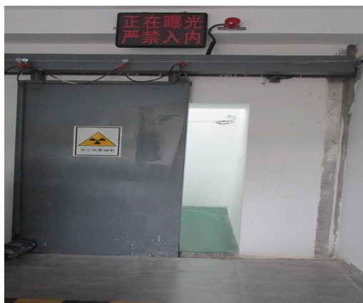
控制室混凝土铅门
