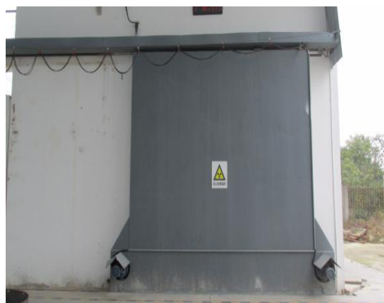
探伤室混凝土铅门
