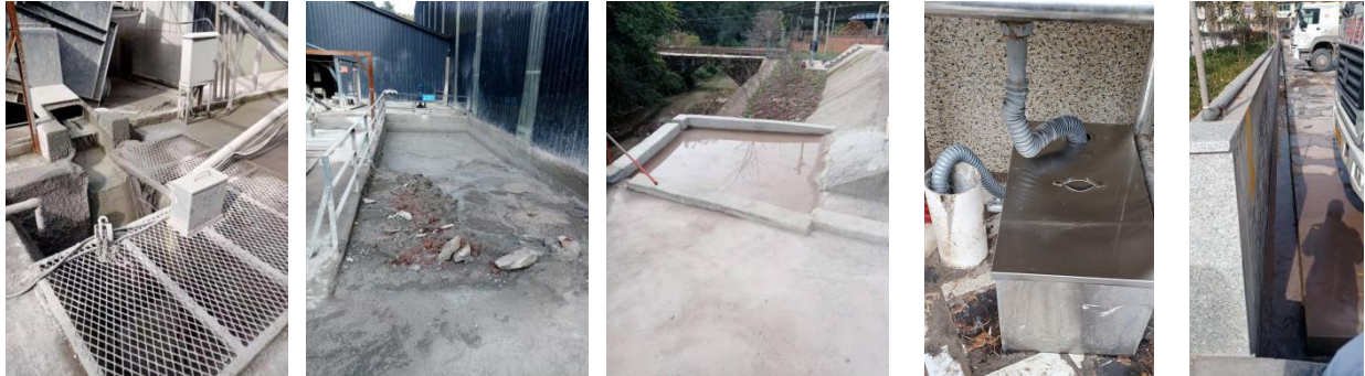
图 3-3 浆水储存池 图 3-4 斜坡沉淀池 图 3-5 雨水沉淀池 图 3-6 食堂隔油池 图 3-7 厂区雨水沟
